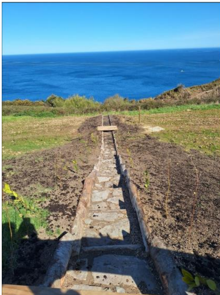
Bajante con técnicas de bioingeniería en talud norte
