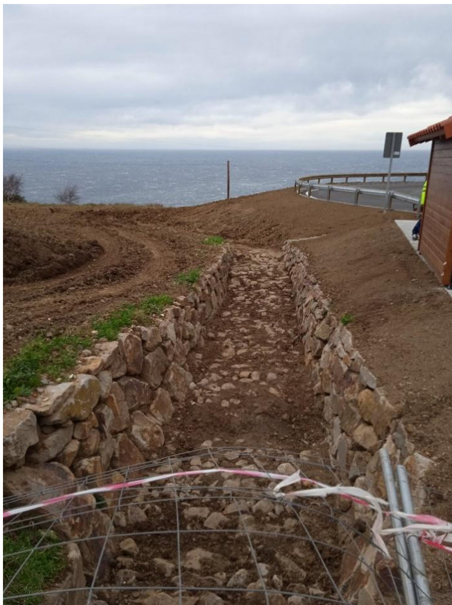
Retacado con tierra de las piedras de los canales de drenaje laterales
