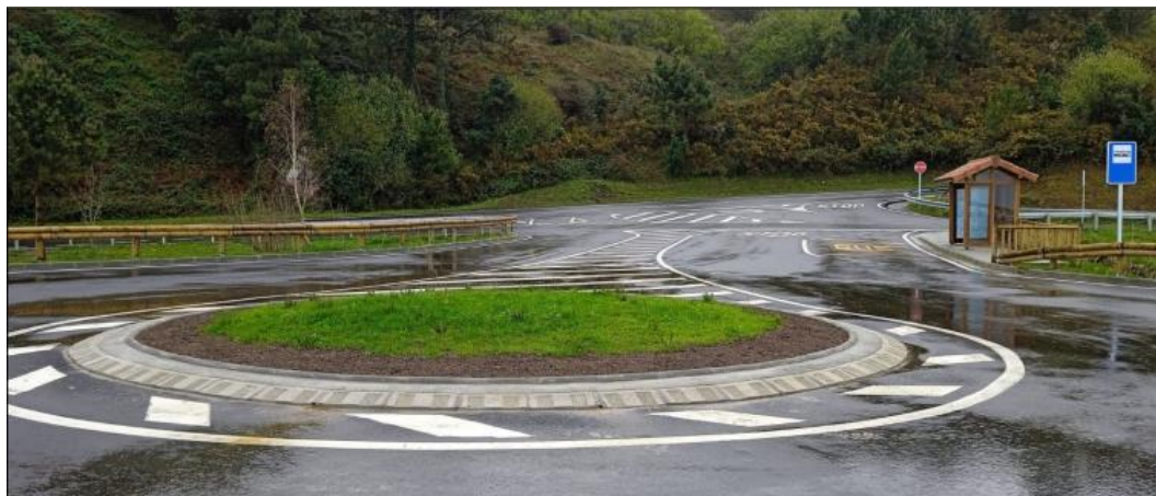
Isleta central tras la reducción del hormigón
