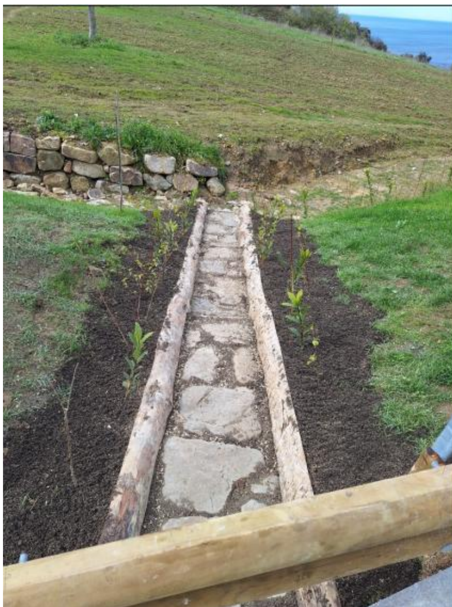
Bajante con técnicas de bioingeniería en talud oeste
